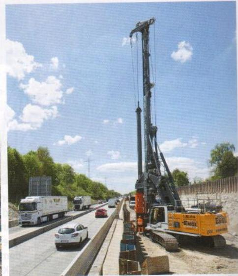
Dank seiner kompakten Abmessungen eignet sich das Liebherr-Drehbohrgerät LB 24-270 von Liebherr für Bohrarbeiten in unmittelbarer Nähe der Autobahn, wo es an der Pfahlgründung der neuen Autobahngalerie bei Germering arbeitet.
